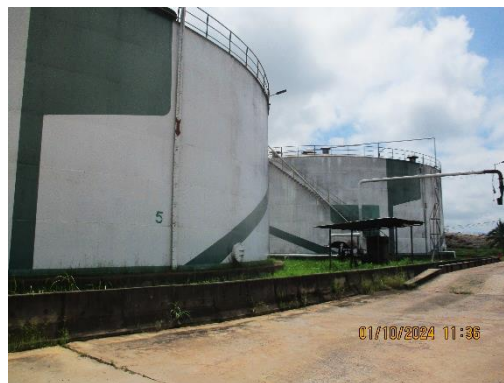
รูปที่ 32 ลานถังเก็บกากน้ำตาล และคันคอนกรีต
